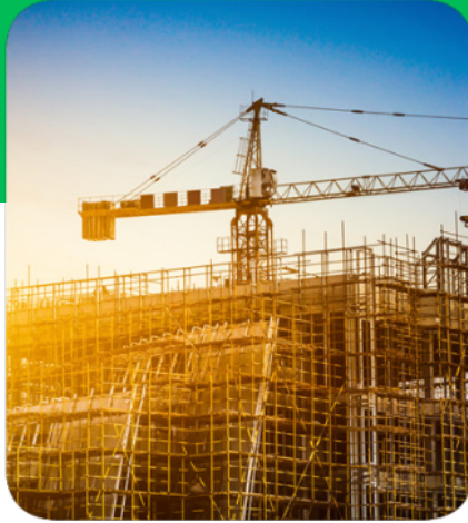
งานโครงสร้าง
